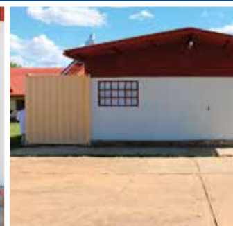
Processing facility at Roodeplaat at ARC-VOPI, Roodeplaat
